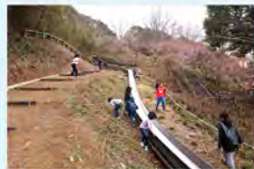
勝間田公園滑り台リニューアル
